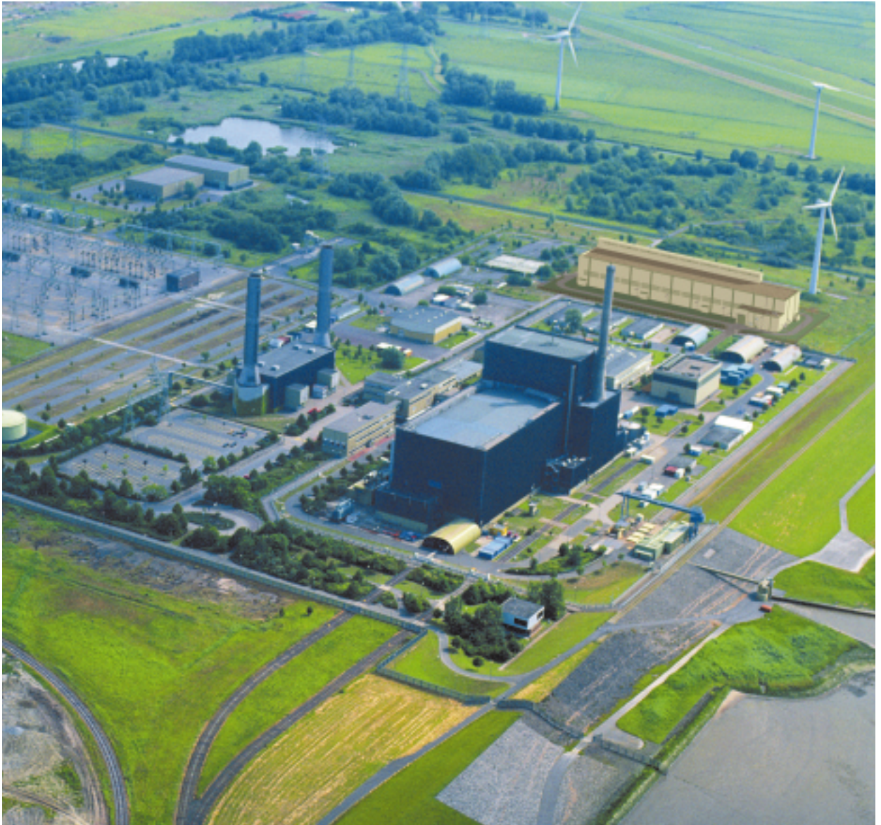
DES STANDORT-ZWISCHENLAGERS BRUNSBÜTTEL AM KERNKRAFTWERK BRUNSBÜTTEL
